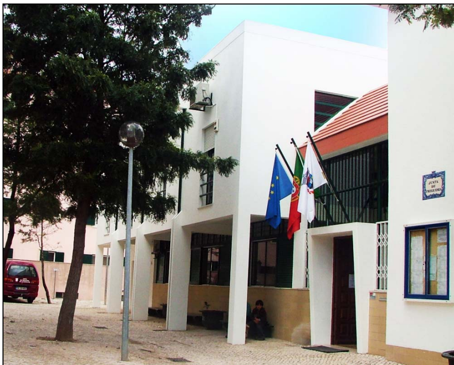
(Sede da Junta de Freguesia de Alcabideche)
