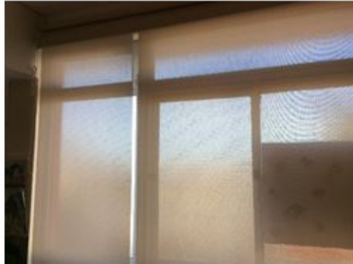
Colocação de redes mosquiteiras
