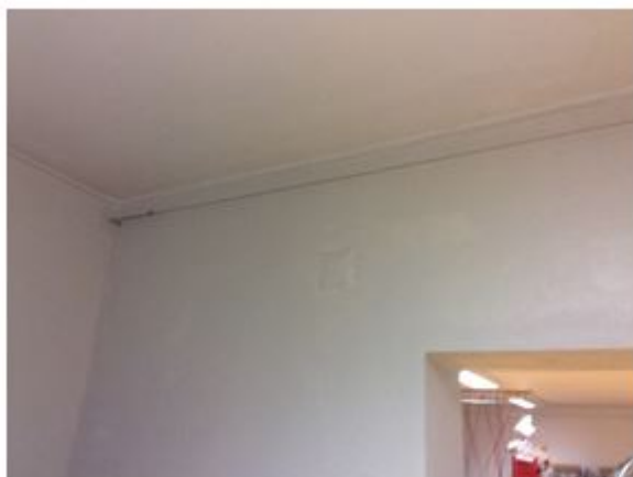
Colocação de suportes de aço e Lâmpadas
