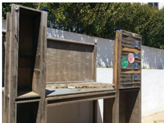
Requalificação de espaço exterior - remoção
