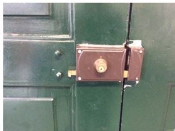
Colocação de fechaduras
