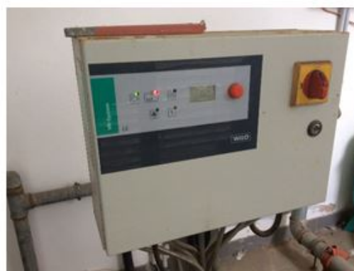
Reparação de equipamento de aquecimento de água
