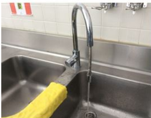
Reparação de torneira e canalização
