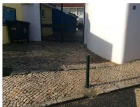
Colocação de pilarete
