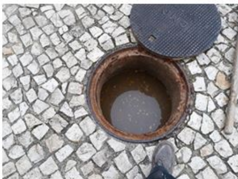
Desentupimento de esgotos Remodelação do espaço da cozinha
