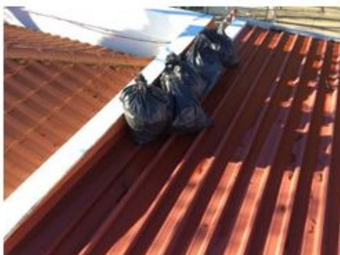
Limpeza de telhados
