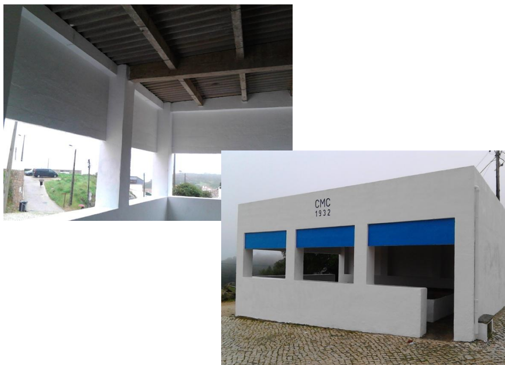
Tanques da Malveira
